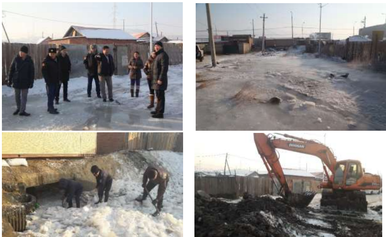
Техник засвар үйлчилгээний ажил хийгдэж байгаа байдал
